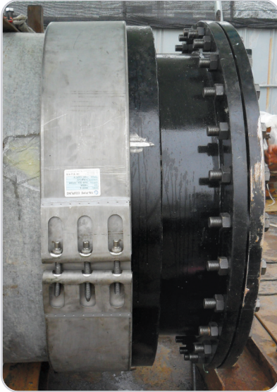
YN - COUPLING RCD - L3 (Width 300mm) 300A~3,000A
